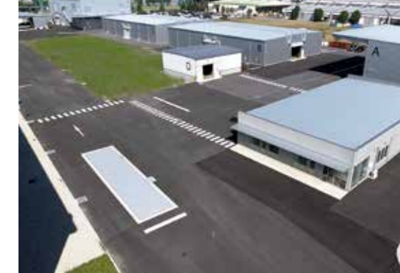
21年開設の行田事業所。東日本エリアの原料・製品の在庫、高純度化や配合などの製造、物流の拠点となった
